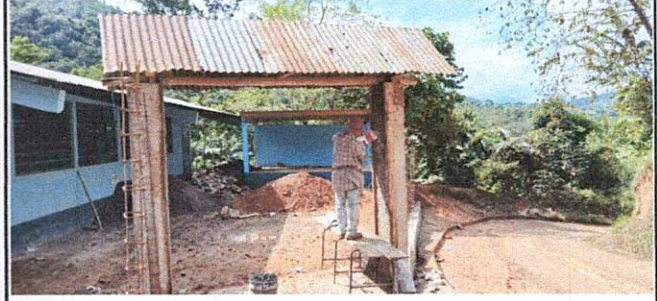
Foto 2: Repello de las columnas principales para la puerta.
