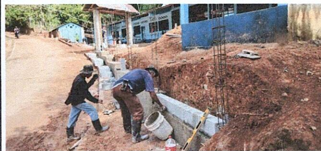
Foto 3: inicio del muro perimetral utilizando block
