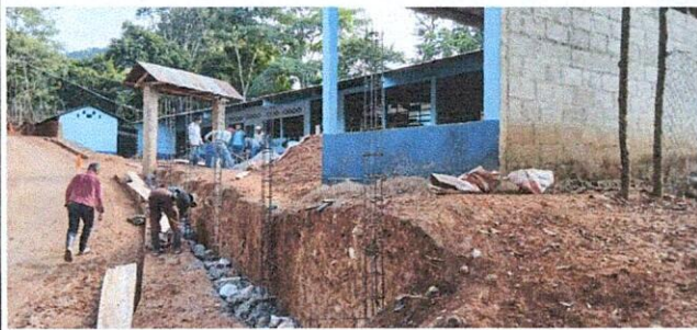
Foto 1: Fundición del cimiento corrido, con piedra y arena
