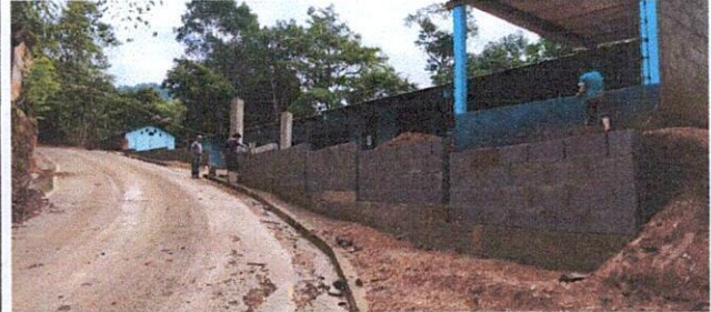
Foto 4: trabajo en la instalación de las hiladas de block
